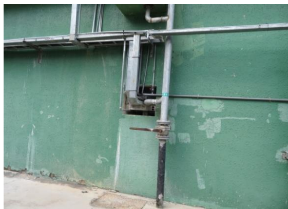
图 5.1.4 生产废水回流阀
