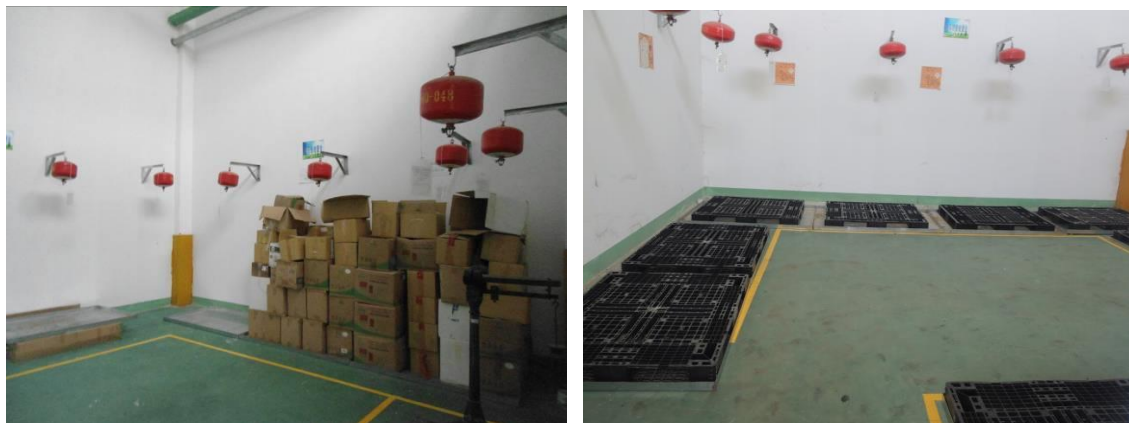
图 5.1.2 危险废物贮存场所
