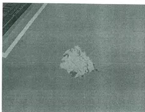
利用锯末对油污进行覆盖，并依照泄漏情况立即封堵泄露容器
