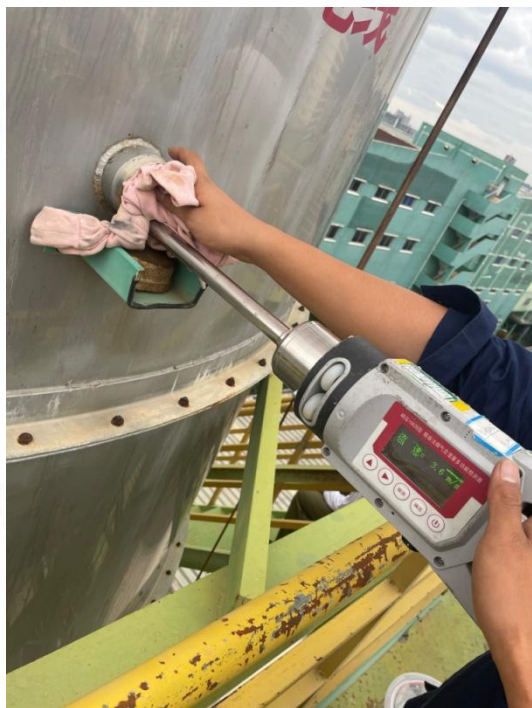
505 车间总排口 (DA016)
