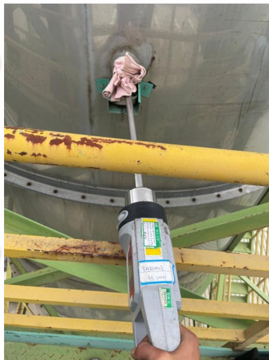
105/205 车间总排口 (DA004)
