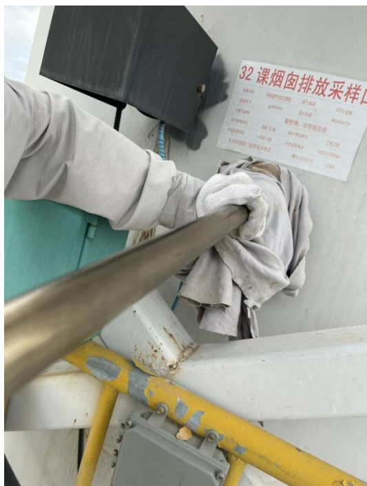
301 车间总排口 (DA002)
