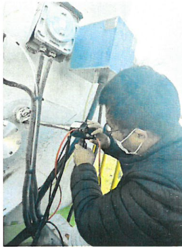
101 混炼车间废气处理设施 排气筒出口 (FO-440201)
