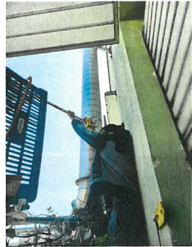
104 检修排气筒出口 (FO-440212)
