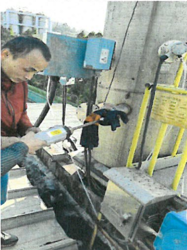
205 淋幕车间排气筒 (FQ-440202)
