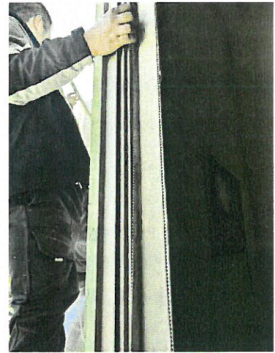
106 配料室排气筒 1#出口 (FO-440215)
