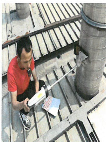
303 车间硫化车间排气筒出口 (DA010/10 号排气筒)
