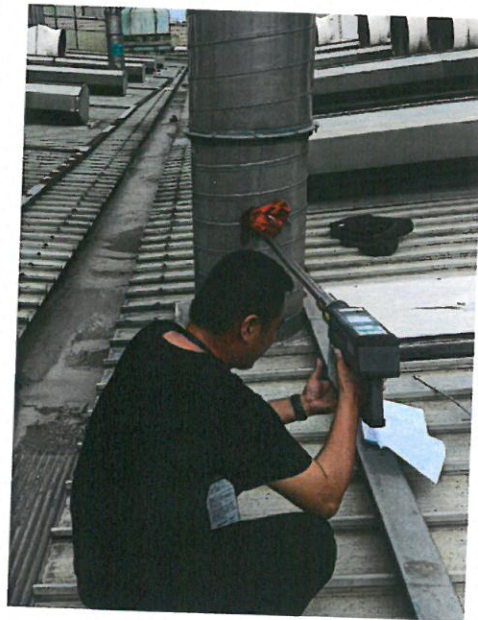
303 硫化车间排气筒出口 (DA010/10 号排气筒)
