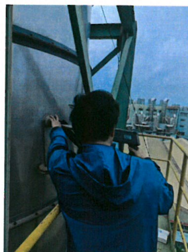
203 车间硫化车间排气筒出口 (DA0027/27 号排气筒)
