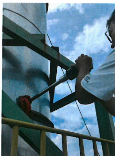
503 车间硫化车间排气筒出口 (DA023/23 号排气筒)
