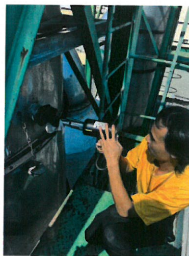
504 车间硫化车间排气筒出口 (DA024/24 号排气筒)
