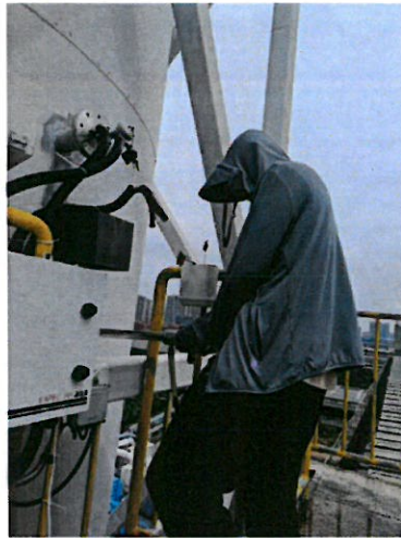
501 混炼车间排气筒出口 (DA003)
