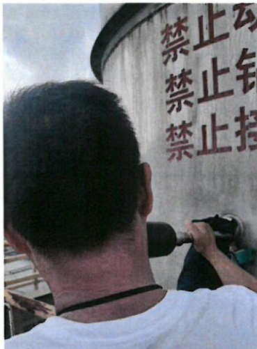
505 硫化车间排气筒出口 (DA016)
