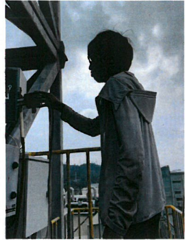
1 混炼车间排气筒出口 (DA001)
