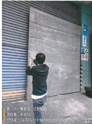
303 硫化车间西北侧门外 1 米
