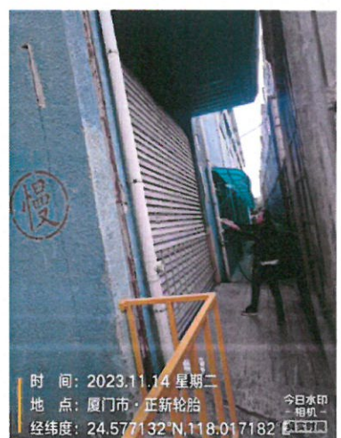
504 加硫车间西侧门外 1 米
