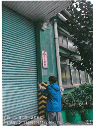
203 硫化车间北侧门外 1 米
