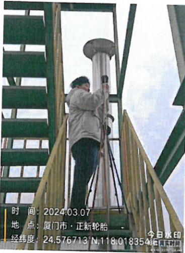
303 洗模车间排气筒出口 DA065 (厂内编号 DA065)
