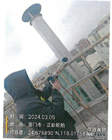
504 洗模车间排气筒出口 DA064 (厂内编号 DA064)
