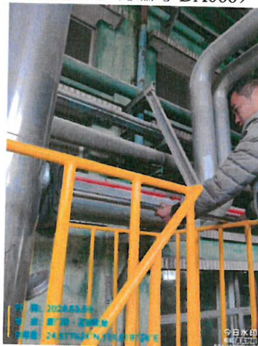
08 洗模车间排气筒出口 DA061 (厂内编号 DA061)
