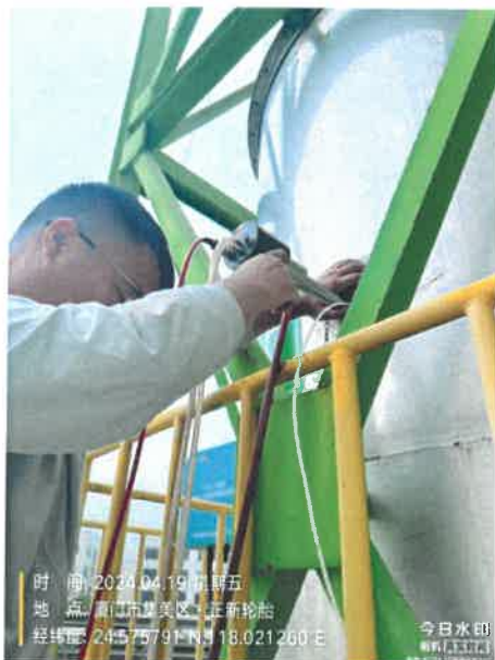
701混炼车间排气筒出口DA014 (厂内编号 DA003)
