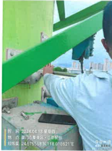
306 车间硫化车间排气筒出口 DA015 (厂内编号 DA029)
