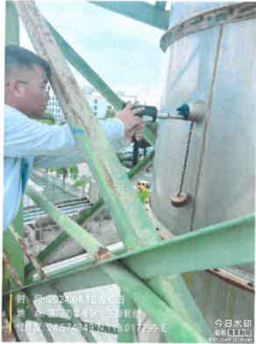
203 车间制品车间排气筒出口 DA053 (厂内编号 DA028)
