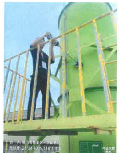
05 车间硫化车间 排气筒出口 DA043 (厂内编号 DA006)
