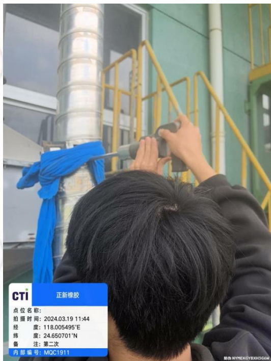
101B 配药 4#排气筒
