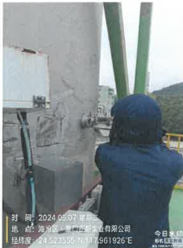
102A 押接排气筒出口 (FQ-440206)
