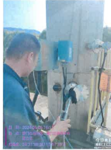
205 淋幕车间排气筒 出口 (FQ-440202)
