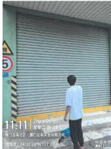
101 车间北侧门外 1 米处
