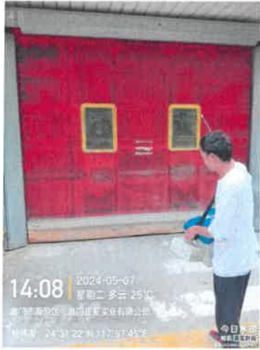
102B 车间南侧门外 1 米
