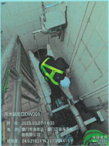
污水站出口 (DW001)
