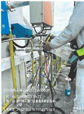
501 混炼车间总排口 (DA003)
