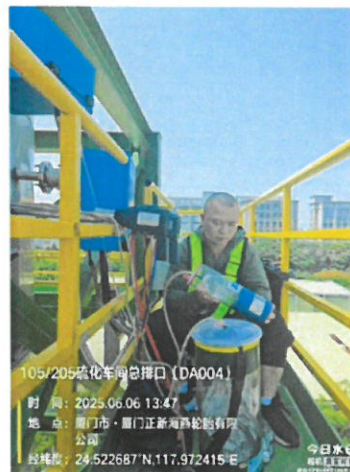
105/205 硫化车间总排口 (DA004)
