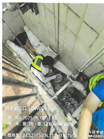
污水站出口 (DW001)
