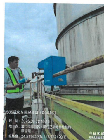
505 硫化车间总排口 (DA016)
