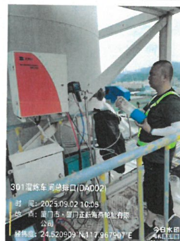
301 混炼车间总排口 (DA002)
