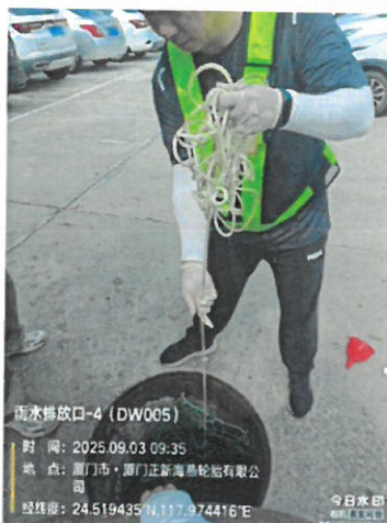
雨水排放口-4 (DW005)
